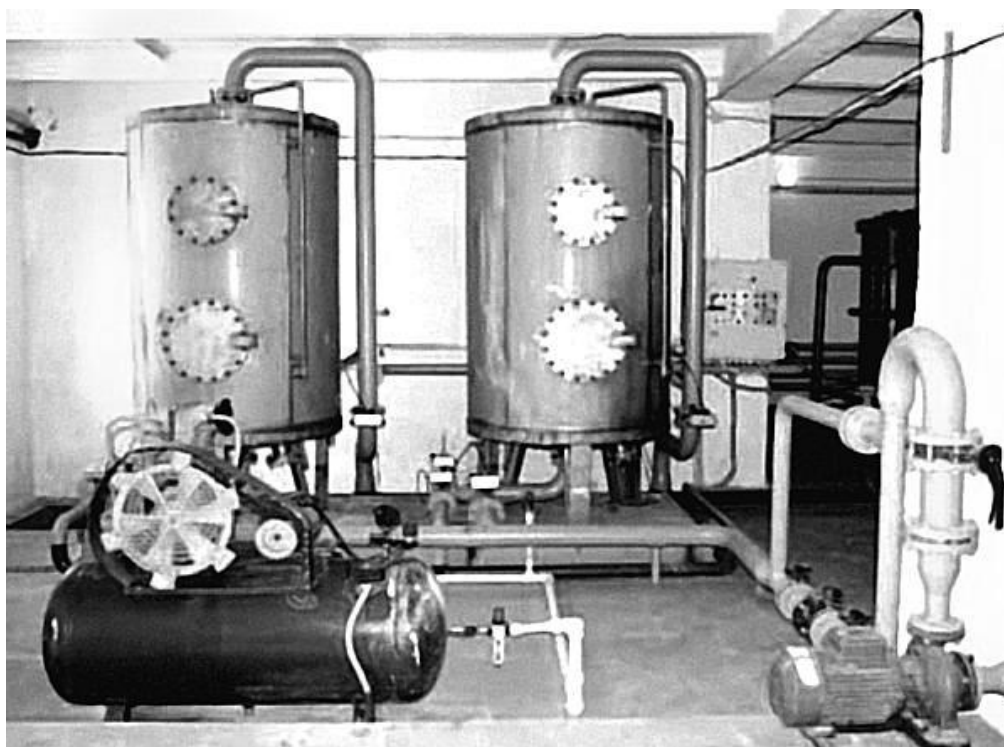
станция очистки и поддачи питьевой воды
